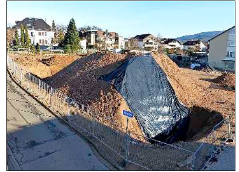
Vom ehemaligen Gasthaus „Grüner Baum“ ist nach dem Abriss im Januar 2022 nur noch ein Schuttberg zu sehen.
